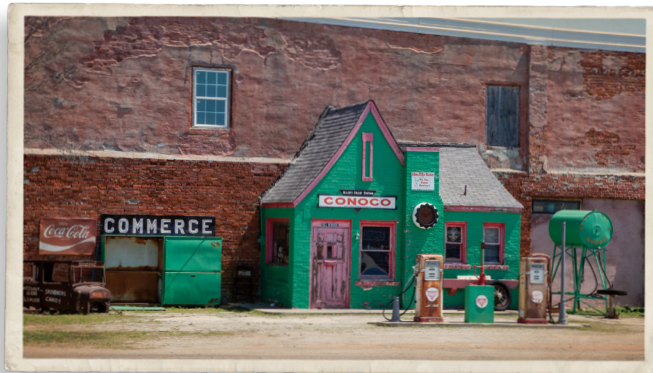
📍 ESTACIÓN DE GASOLINA CONOCO ALLEN'S
